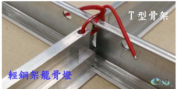
圖 6：將固定鐵絲彎折纏繞三圈側置，完成單邊固定。另一邊重複圖 3～圖 6，固定即完成。
