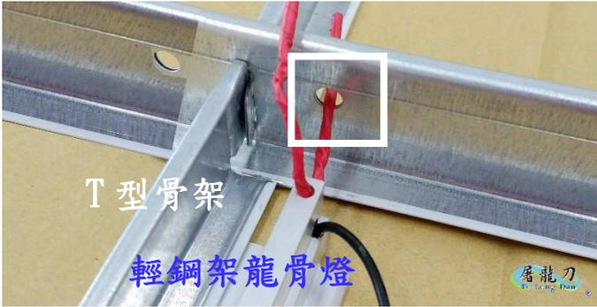
圖 3：再將固定鐵絲穿入輕鋼架圓孔（如白框內所示）。
