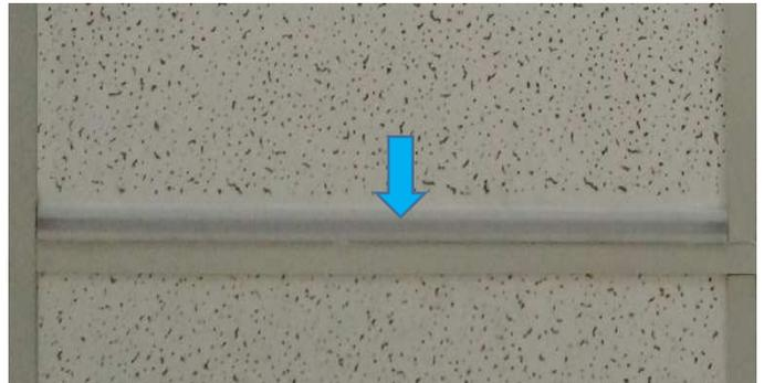
圖 8：安裝完成圖。（輕鋼架龍骨燈以藍色箭頭表示之 ← ）
