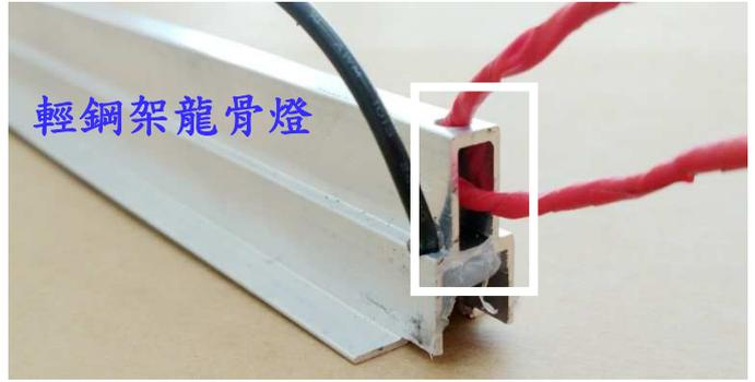
圖 2：於輕鋼架龍骨燈頂端打孔處，穿入固定鐵絲（如白框內所示）。
