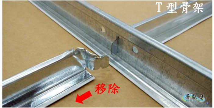
圖 2：換裝者，移除 2 尺輕鋼架。
