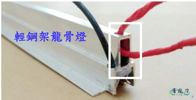
圖 3：於輕鋼架龍骨燈頂端打孔處，穿入固定鐵絲（如白框內所示）。
