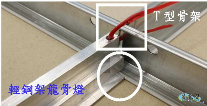
圖 5：將輕鋼架龍骨燈跨置於輕鋼架邊條上（如白圈內所示）。固定鐵絲穿入至底（如白框內所示）。
