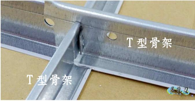
圖 1：確認欲安裝輕鋼架龍骨燈的位置。
