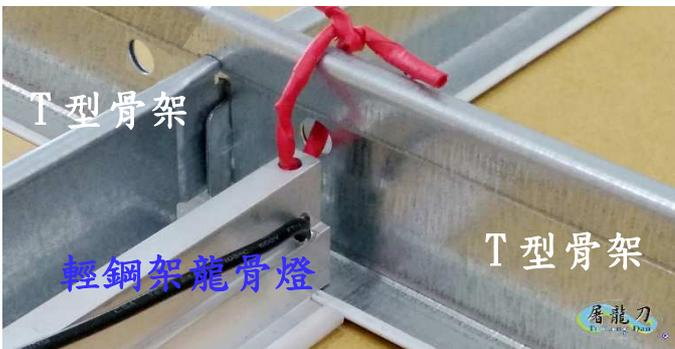
圖 5：將固定鐵絲彎折纏繞三圈側置，完成單邊固定。另一邊重複圖 2～圖 5，固定之。
