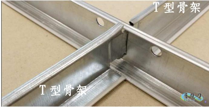
圖 1：換裝者，確認欲安裝輕鋼架龍骨燈的 2 尺輕鋼架。
