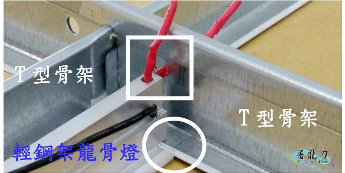
圖 4：將輕鋼架龍骨燈跨置於輕鋼架邊條上（如白圈內所示）。固定鐵絲穿入至底（如白框內所示）。
