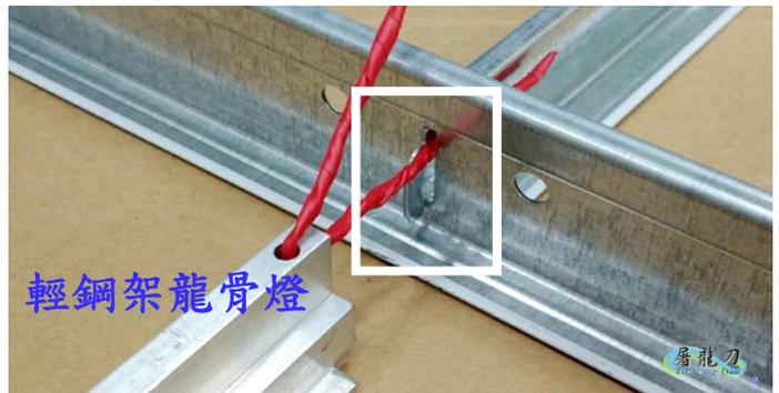
圖 4：再將固定鐵絲穿入輕鋼架固定孔（如白框內所示）。
